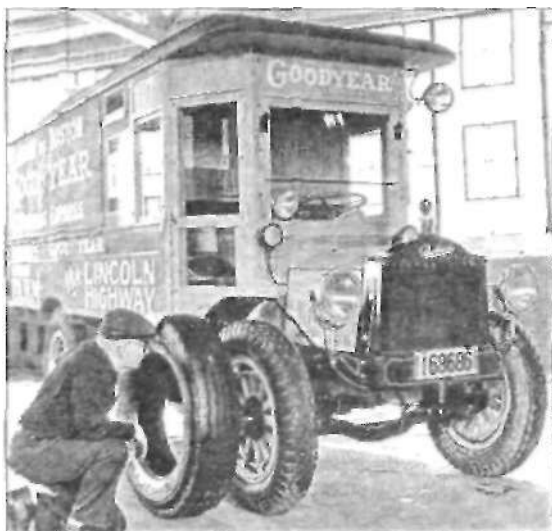
Грузовой автомобиль в 1917 г.: Гудьер поставил пневматическую шину на разъемный обод.
